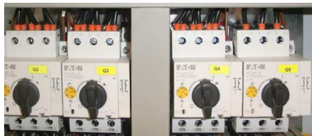
Abb. 1: Motorschutzschalter
